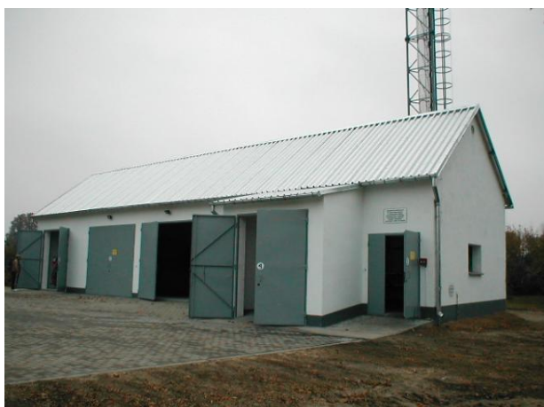
Budynek nowej kotłowni
