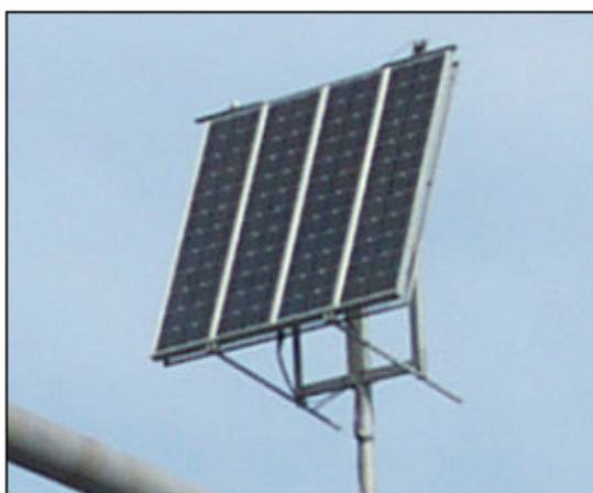
Rusztowanie z modułami PV, na szczycie widoczne krzemowe czujniki promieniowania
