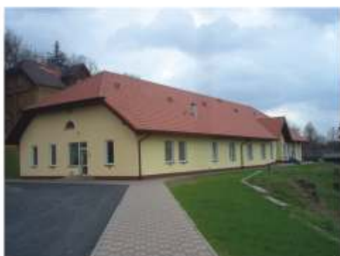
Budynek ośrodka zdrowia
