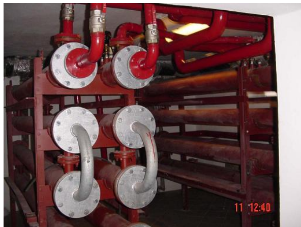
Wymiennik ciepła ścieki/glikol
