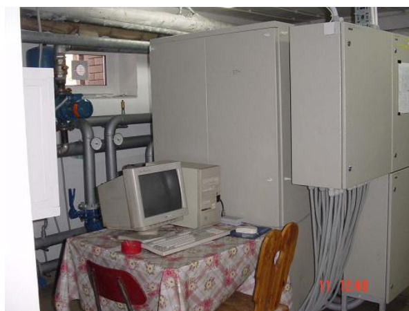
Dwusekcyjna pompa ciepła
