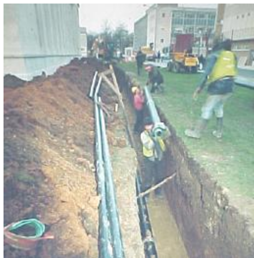
Ryc. 1. Układanie rurociągu sieci wzdłuż Civic Centre
