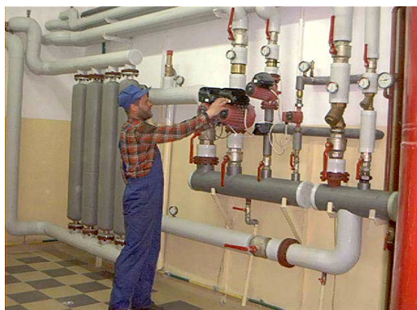
Zdj. 4. Wymienniki JAD 6/50 z zespołem pomp
