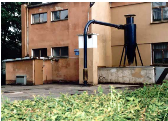
Zdj. 2. Podajnik zrębków typ – „CYKLON”
